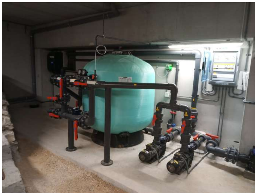
Figura 10. Sistema de tractament de la piscina petita
