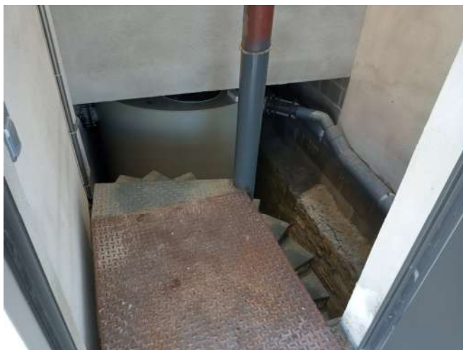
Figura 5. Escales d'accés a la sala de la màquines des de la piscina, vistes des de la part superior
