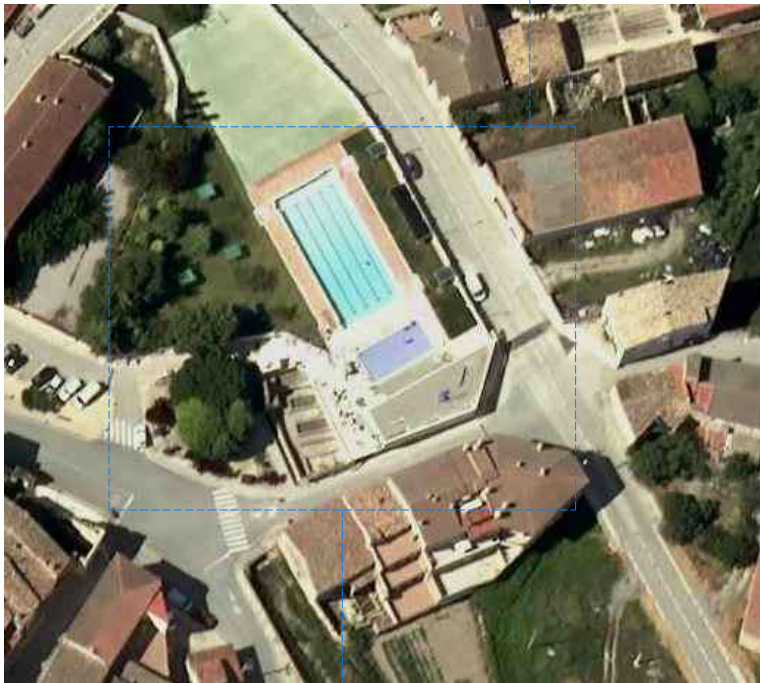
PISCINES MUNICIPALS CARRETERA LA LLACUNA, Nº56
