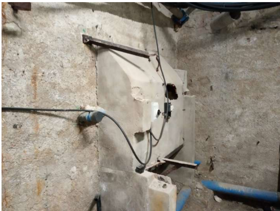
Figura 17. Paret del recinte actual del sistema de tractament de la piscina gran
