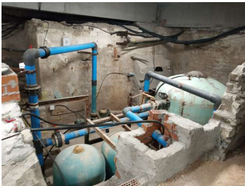
Figura 9. Maquinària actual del sistema de tractament de la piscina
