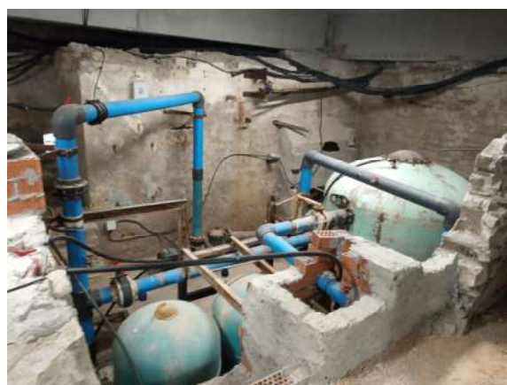
Figura 3: Piscina gran i equips de tractament (estat actual)
