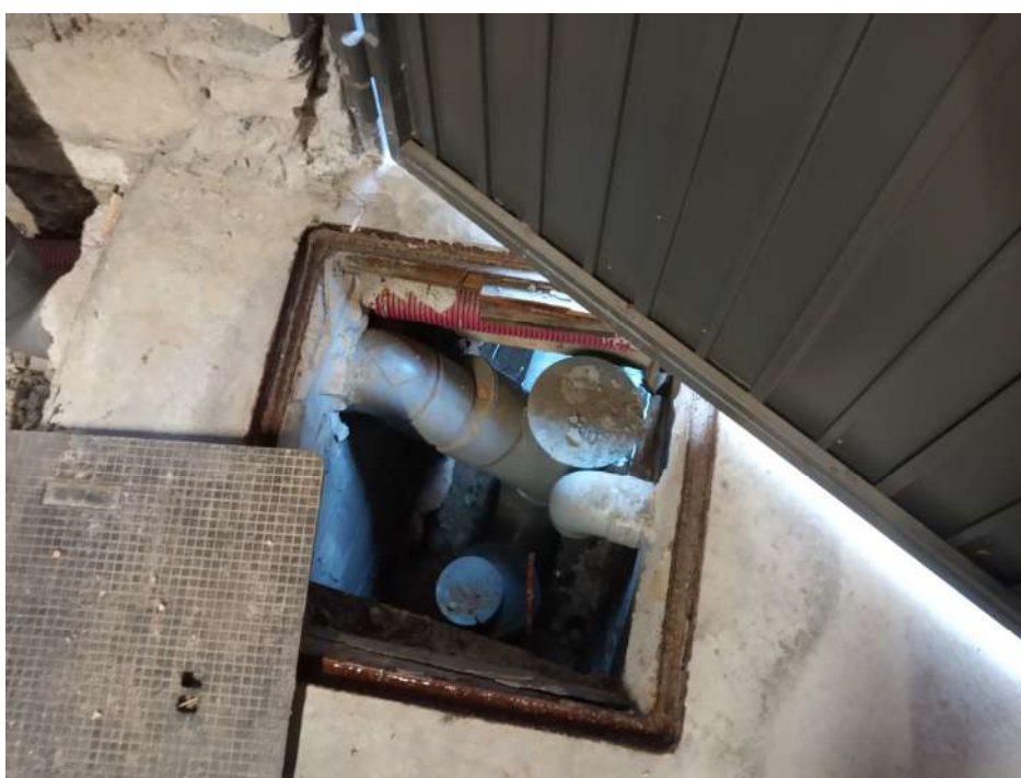
Figura 22. Detall de l'arqueta exterior, situada a la vorera del carrer, del canal d'evacuació de la sala de màquines
