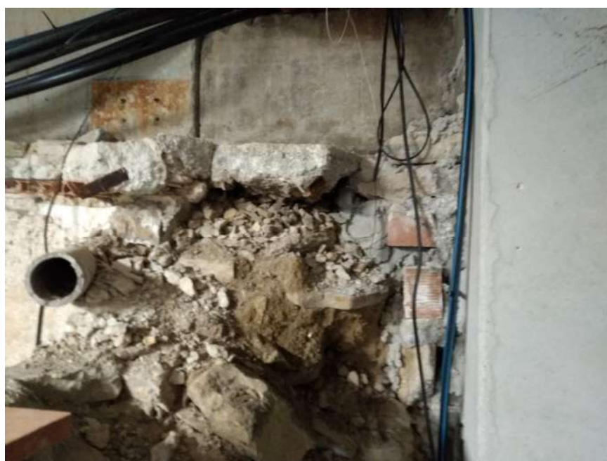
Figura 16. Paret del recinte actual del sistema de tractament de la piscina gran
