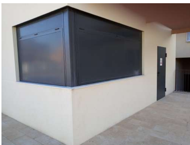
Figura 4. Porta d'accés a la sala de màquines des de la piscina
