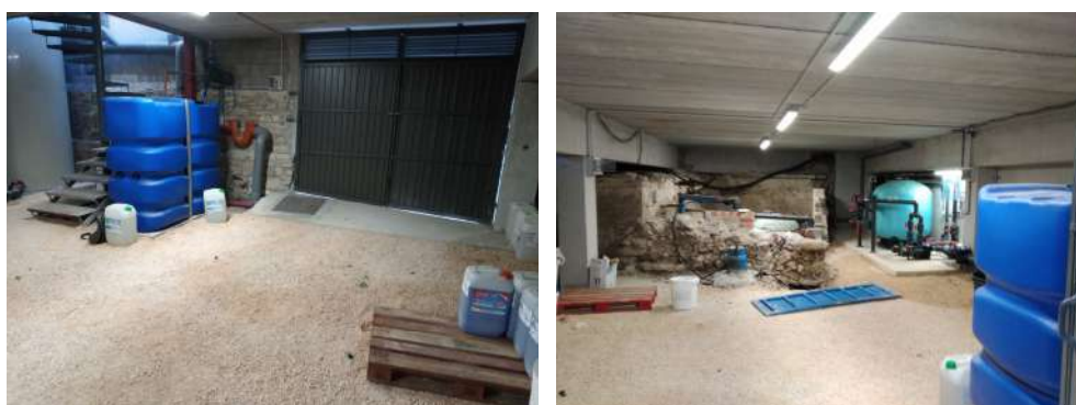
Figura 7: Retirada del sauló existent
