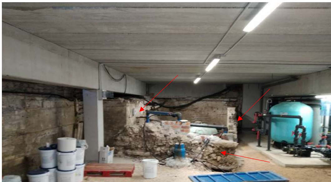
Figura 6: Detall de murs a enderrocar
