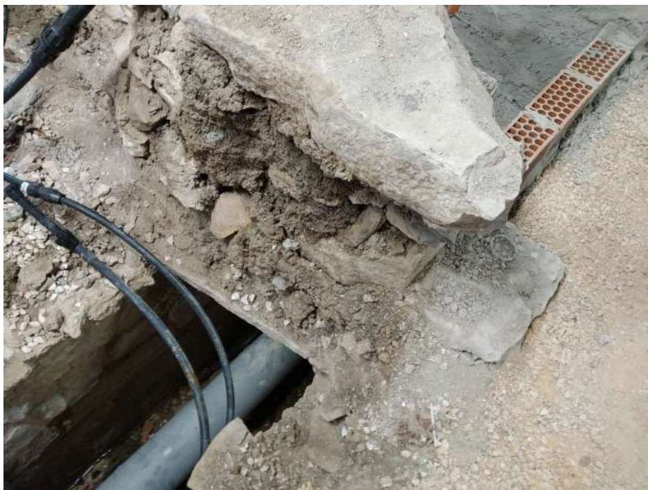
Figura 21. Detall del canal d'evacuació de la sala de màquines
