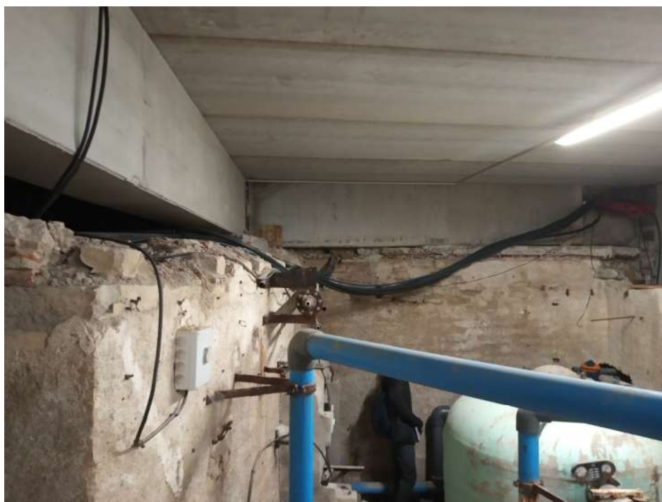
Figura 19. Paret del recinte actual del sistema de tractament de la piscina gran
