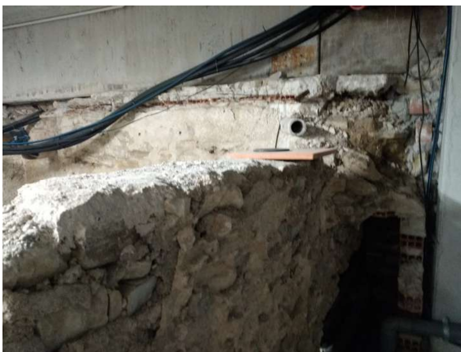
Figura 18. Mur del recinte actual del sistema de tractament de la piscina gran
