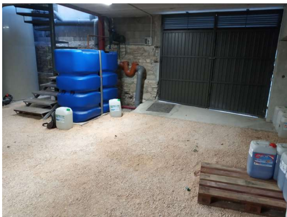
Figura 8. Accés a la sala de màquines des del carrer
