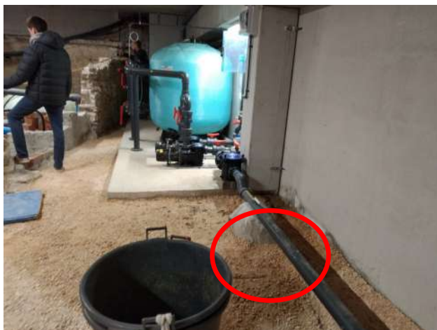
Figura 8: Instal·lació de vàlvula de descàrrega i desaigüe per buidar dipòsit compensació piscina petita
