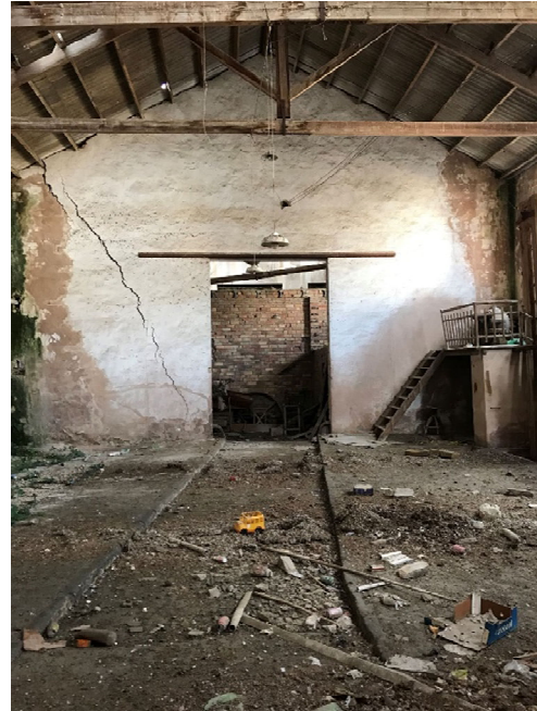
Foto5. Detall mur interior arriostament
