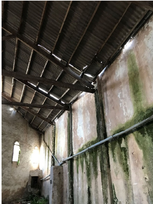
Foto4. Vista interior01. Detall trobada coberta
